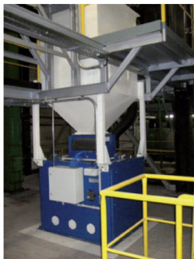
Elektronische Schüttwaage Typ 34.144 gemäß ATEX-Richtlinie. Einsatzort: Riesaer Ölwerke Schutzart:
